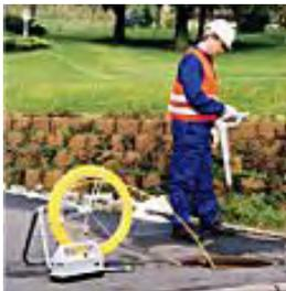
Korištenjem sustava sa priključenom sondom u zavisnosti od metode priključka može se ustanoviti cijela trasa cijevi ili krajnje točke. Kompaktna izvedba sustava i bakreni vodiči integrirani unutar poteznog užeta omogućavaju laku primjenu na gradilištima.
