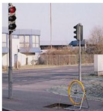
Potezno uže promjera 7.2 mm je otporno na pucanje ali dovoljno savitljivo da se može direktno uvesti u stup nosač semafora.
