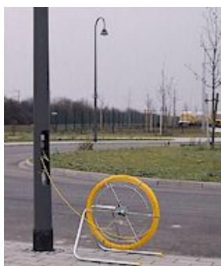
Tipično područje primjene Cable-Jet sistema je instalacija ulične rasvjete. Promjer poteznog užeta je optimiziran za potrebne dužine i presjeke kabela.
