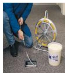
Povlačenje je bitno lakše uz uporabu Glit paste za podmazivanje. Ujedno se produžava radni vijek poteznog užeta i smanjuje habanje kabela.
