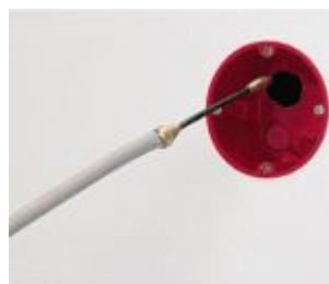
Kod izvođenja kućne instalacije kabeli, vodići, pa čak i antenski kabeli uguravaju se brzo i jednostavno u instalacijske cijevi.
